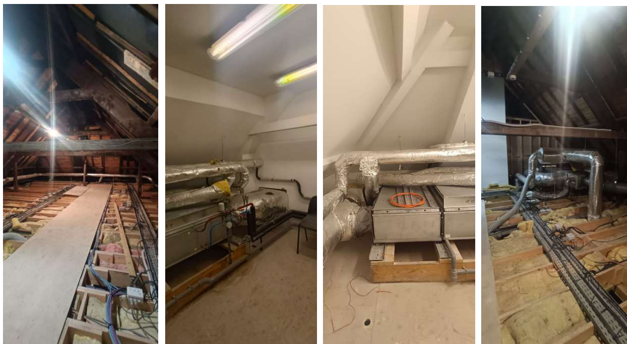
Figure 2 : Photo des combles et du seul local cloisonné : le local CTA.
